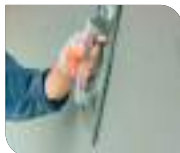
Aplicação em reboco.
