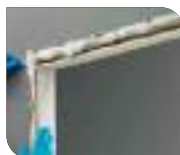
Preenchimento de batente de porta.
