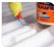
Aplicação em laje sem trânsito.
