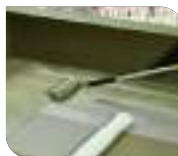
Aplicação como reforço de impermeabilização.
