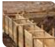
Aplicação em fôrma de madeira.
