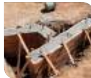
Aplicação em fôrma de madeira.
