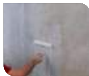
Aplicação em parede.
