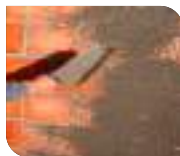
Aplicação em argamassa de chapisco.
