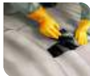
Aplicação em telhados.
