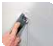
Aplicação em fissuras.
