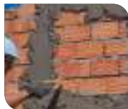
Aplicação em reboco.
