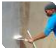
Aplicação em paredes externas.
