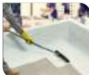
Aplicação em laje sem trânsito.
