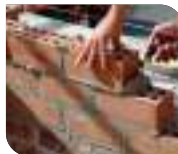
Aplicação em argamassa de assentamento.
