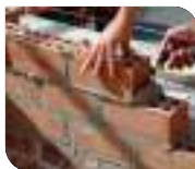
Aplicação em argamassa de assentamento.
