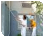
Aplicação em paredes externas.
