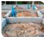
Aplicação em fundação.
