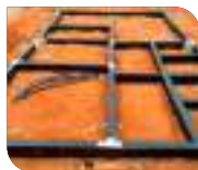
Aplicação em fundação/ alicerce.
