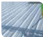
Aplicação em laje sem trânsito.
