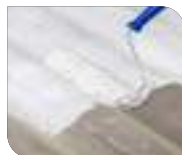
Aplicação em telhas de cimento.
