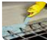
Aplicação como ponte de aderência entre concreto velho e novo.
