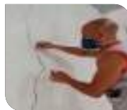
Aplicação em fissuras.
