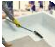
Aplicação em laje sem trânsito.
